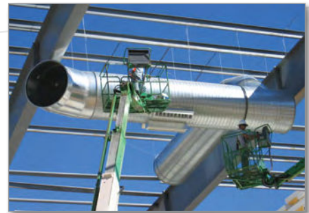
Gripple en la industria de la construcción
