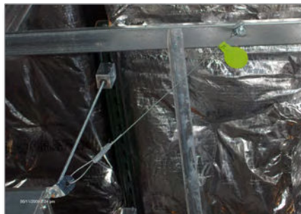
Arriostamiento de ductos
